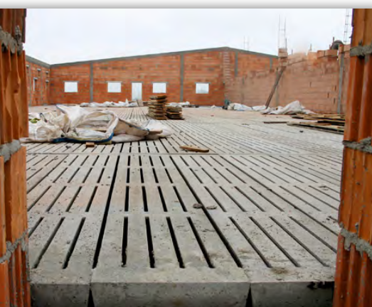
Rolnik zdecydował się na system rusztowy z szerokością szczeliny 17 mm
